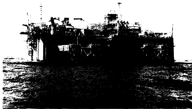
Il rigassificatore Terminal Gnl Adriatico posizionato a 15 km dalla costa di Rovigo e di proprietà di Exxon mobil, Qatar petroleum ed Edison
